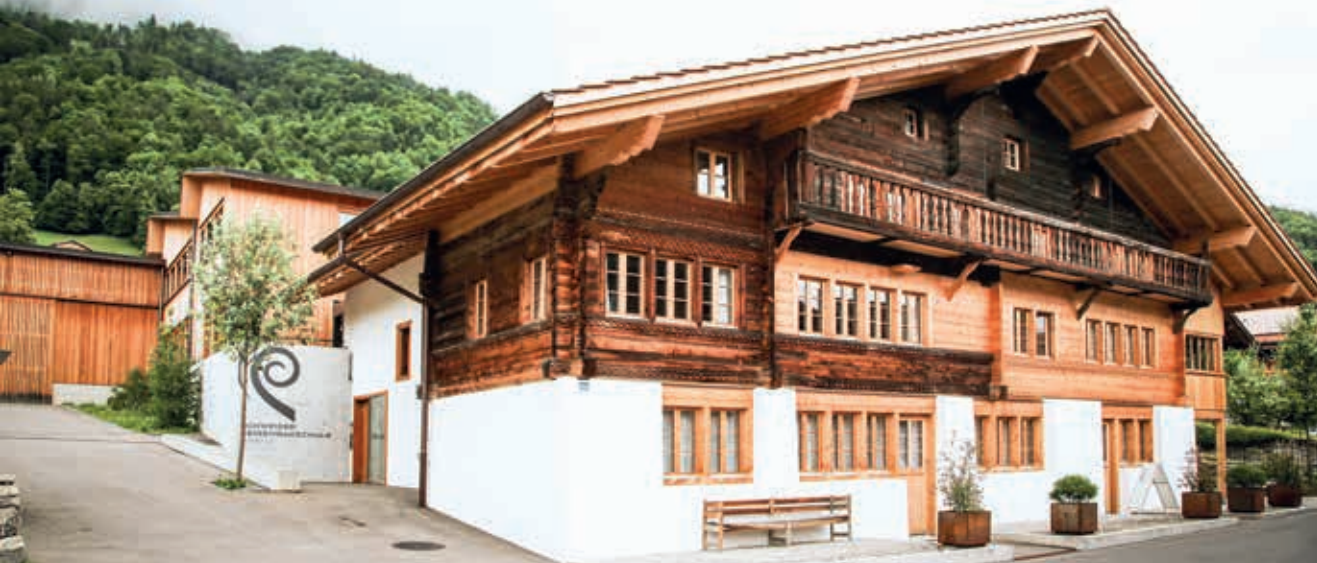
Die renovierte und ausgebaute Geigenbauschule
